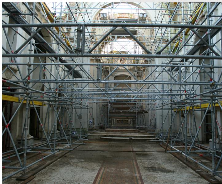
Fig. 2 - Strutture di contenimento delle pareti e di sostegno della copertura provvisoria
