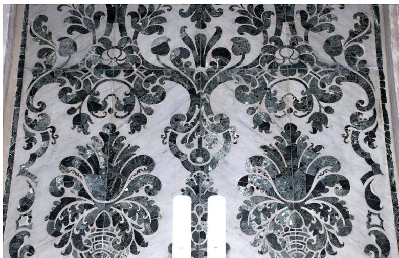
Sono inoltre state svolte azioni di consolidamento del pavimento dell'area del presbiterio, mediante localizzate stuccature e integrazioni di elementi marmorei dell'apparato decorativo.
