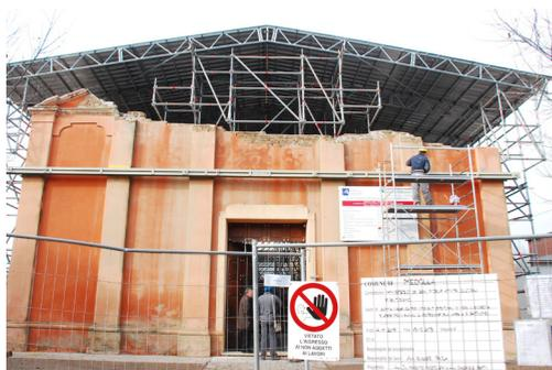
Fig. 6 - Realizzazione della copertura provvisoria
