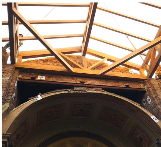
Fig. 4 - Particolare della copertura provvisoria
