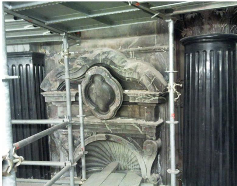
Nello specifico, al primo livello della Cappella, interamente realizzato in marmo nero, sono state smontate e sostituite, dopo aver messo a punto e realizzato i sistemi provvisori necessari, 13 colonne dell'ordine minore, tutte le lesene dell'ordine maggiore (previi i consolidamenti alla base delle stesse), le colonne e i conci dell'arco sghembo di affaccio verso il Duomo e quelli della trabeazione del vestibolo Nord-Ovest.
