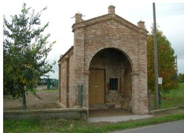
Fig. 10 - L'oratorio dopo l'intervento di messa in sicurezza e ricostruzione
